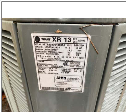
Exterior AC unit 4928
